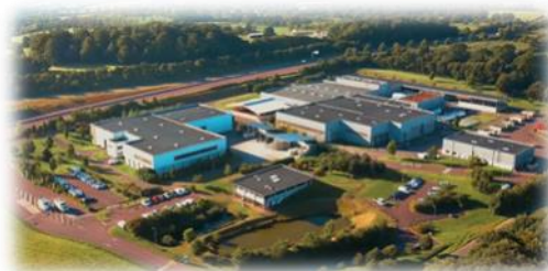
Pôle de valorisation de Cavigny - 2021
